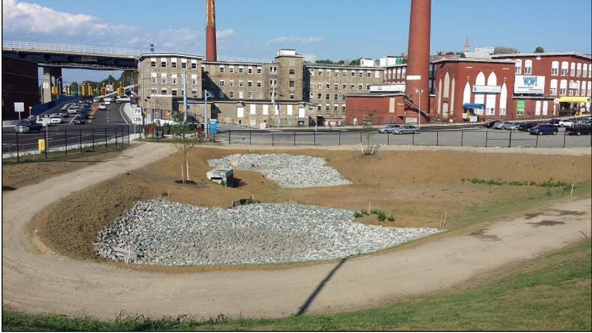
Şekil 21-2 Şehir İçinde Taşkın Önleme Amacıyla İnşa Edilmekte Olan Bir Sızdırma Alanı ( https://en.wikipedia.org/wiki/Infiltration_basin )
