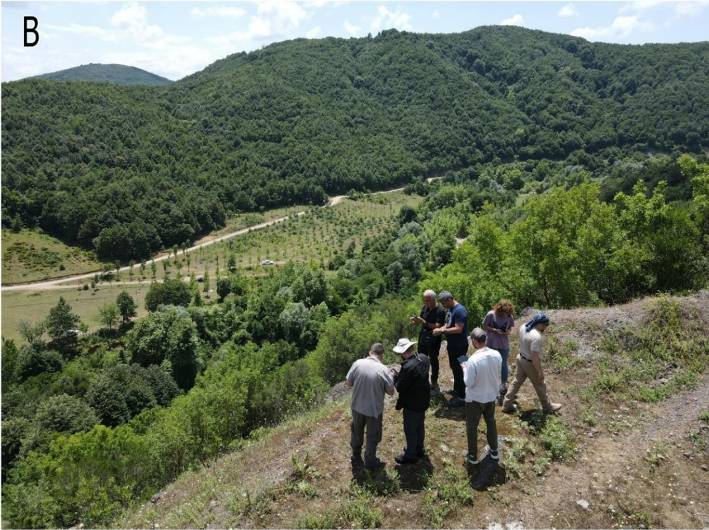
Şekil 5.46 Proje ekibi tarafından saha çalışmasında kontrolü sağlanan Avcıkoru / Şile yakınlarında hafriyat döküm alanında gelişen heyelan (A) ve Darılık Barajı / Şile mevkiinde akarsu yan yamaçlarında gelişen heyelanlar (B)
