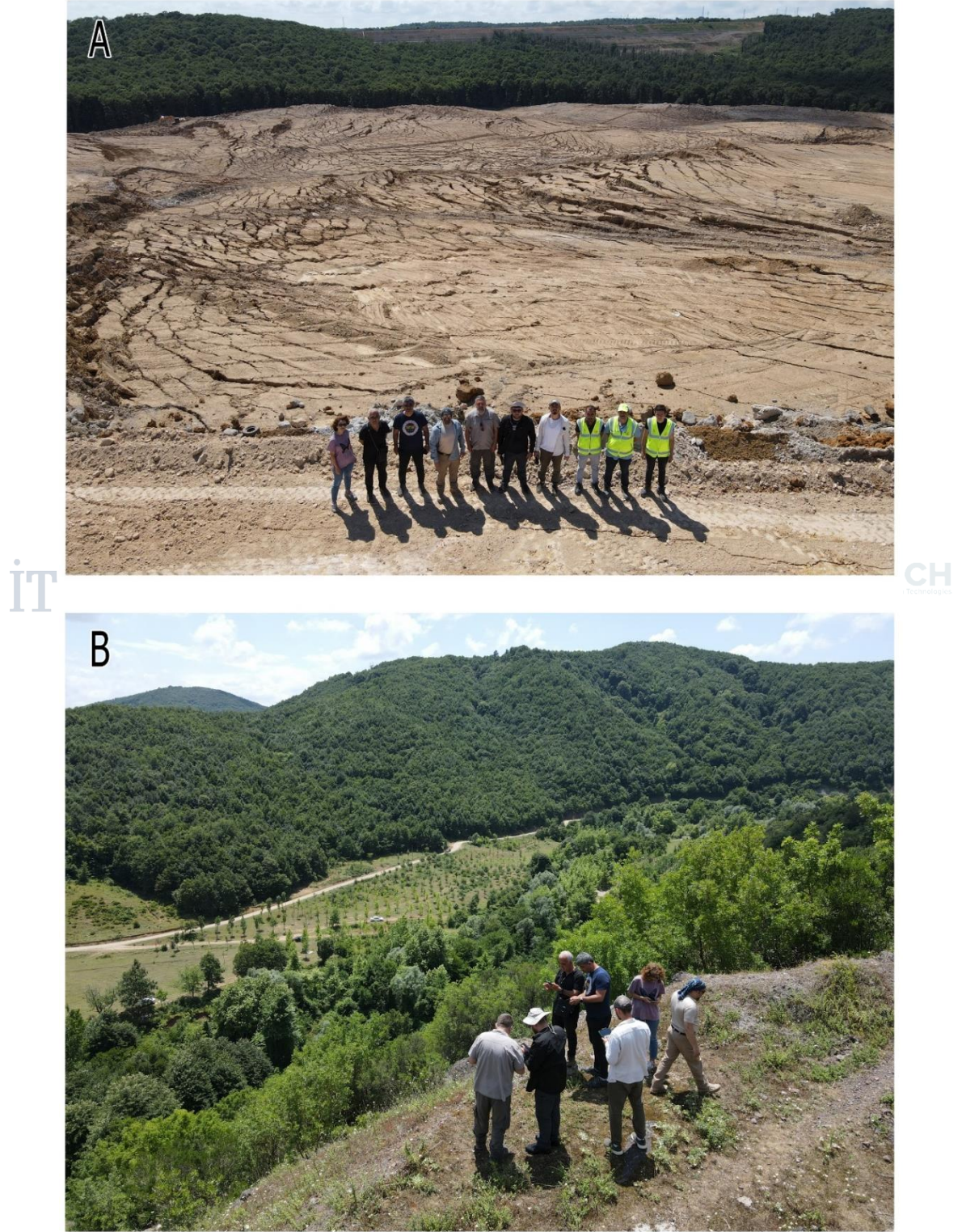
Şekil 3.20. Proje ekibi tarafından saha çalışmasında kontrolü sağlanan Avcıkoru / Şile yakınlarında hafriyat döküm alanında gelişen heyelan (A) ve Darılık Barajı / Şile mevkiinde akarsu yan yamaçlarında gelişen heyelanlar (B).
