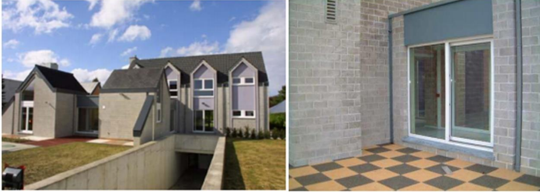
Şekil 14. RECYhouse – Belçika (sol); Yağmur oluğu, Pencere ve Döşeme Kaplaması (sağ)
