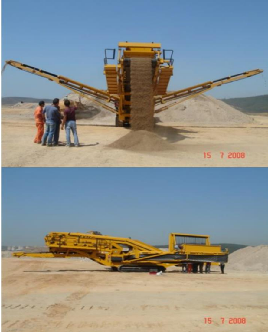
Şekil 17. İ.B.B. Tuzla inşaat ve yıkıntı atıkları geri dönüşüm tesisi
