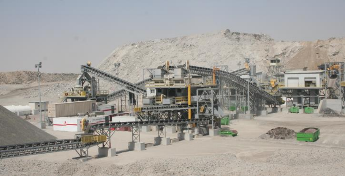
Şekil 13. Abu Dabi-Al Dhafra geri dönüşüm tesisi ( http://www.aldhafrarecycling.ae/en/?sw=capabilities )
